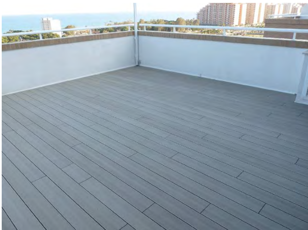
25. Tarima montada a junta perdida.
