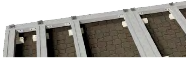
33. Inicio de instalación con clip de inicio.
