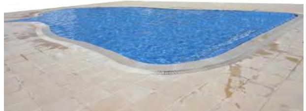
1. Piscina con suelo de hormigón, ejemplo de suelo apto para atornillar.
