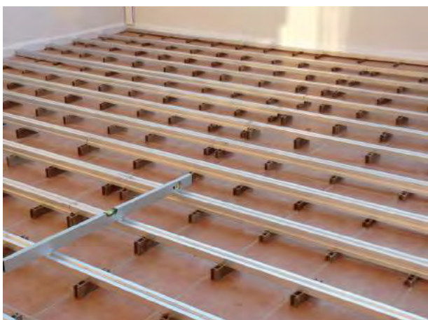
23. Rastrelado para junta perdida.
