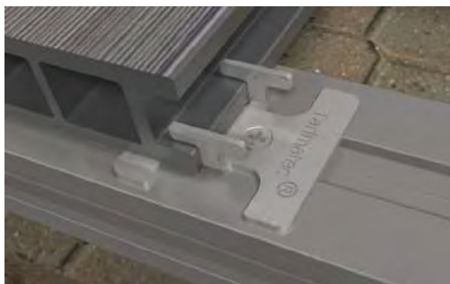
18. Detalle de sujeción de lama con clip
