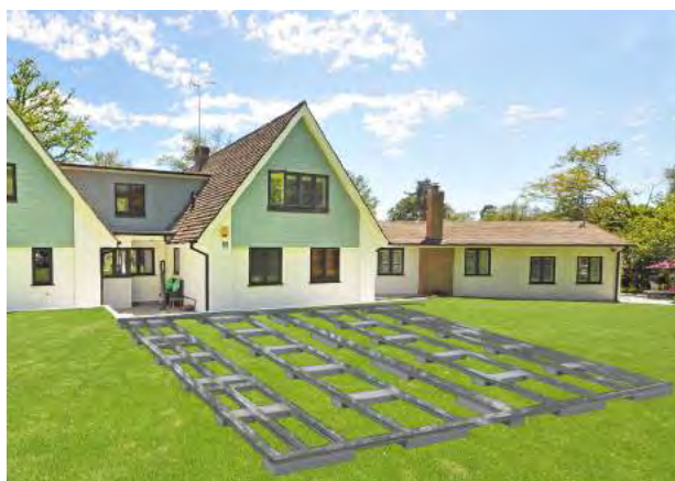
13. Estructura rastrelado con losetas.
