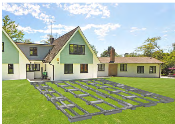
13. Estructura rastrelado con losetas.
