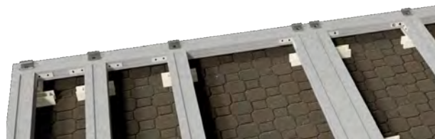
33. Inicio de instalación con clip de inicio.
