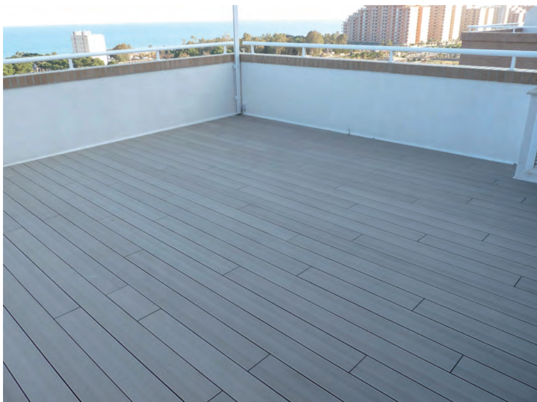
25. Tarima montada a junta perdida.
