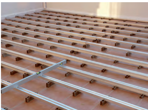
23. Rastrelado para junta perdida.
