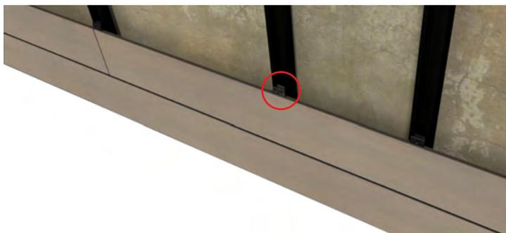
Este sencillo sistema, permite la dilatación y contracción de la pieza, pero evita que debido a estas dilataciones y contracciones, la pieza se pueda ir desplazando lateralmente, provocando que, además de variar el aspecto visual de la fachada, alguna testa pueda perder el contacto con el clip.
