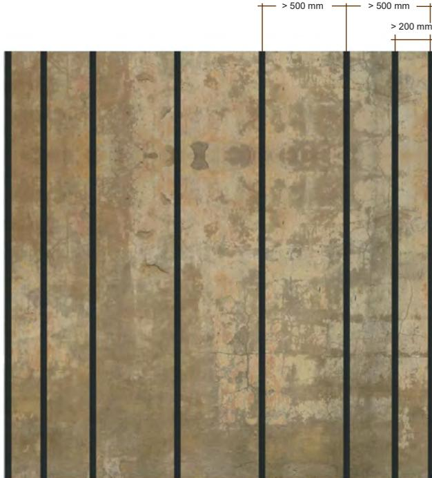
Como se aprecia en la imagen anterior la separación entre rastreles no será superior a 500 mm. En los extremos, entre el primer y el segundo rastrel, se colocará uno intermedio cuya distancia no será superior a 200 mm del primer rastrel.
